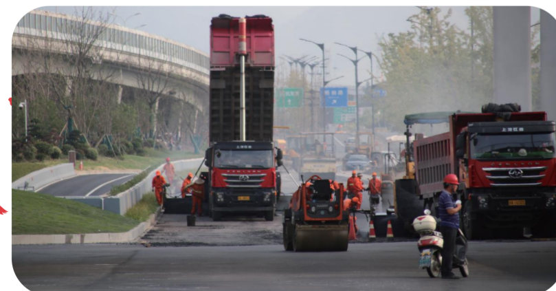
之浦路节前完成隧道通车，之浦路路面层沥青即将摊铺完成。
